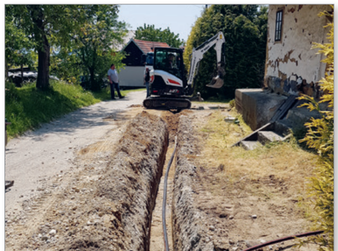
Polaganje kabelske kanalizacije za optično omrežje v naselju Stanetinci
