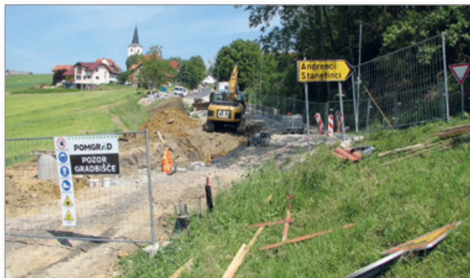
Sanacija cestnega plazu v smeri stanetinske doline
