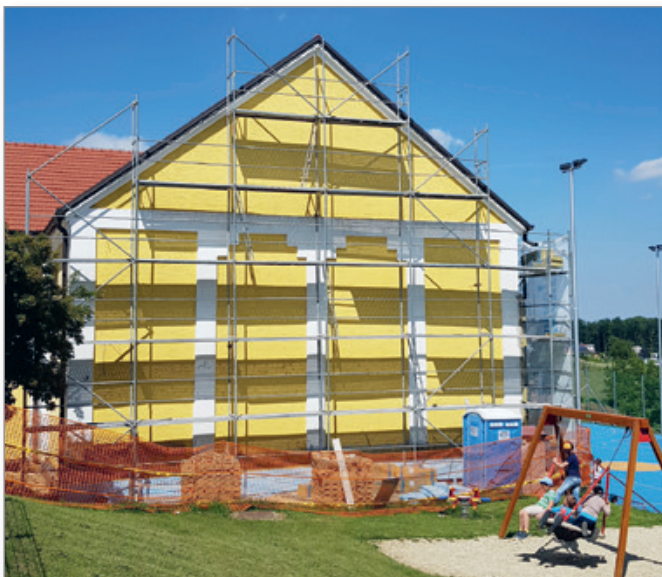
Objekt OŠ Cerkevjak že dobiva nov plašč.
